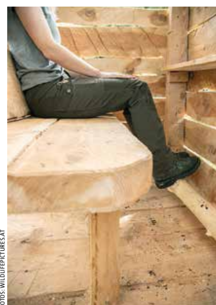
Innenausstattung. Richtig bequem machen den Sitz die leicht schräge Rückenlehne mit der Aussparung für das Schusstangl, natürlich das Ablagebrett unter der Brüstung für Spektiv und Speck sowie ein Rundling als Fußablage.
