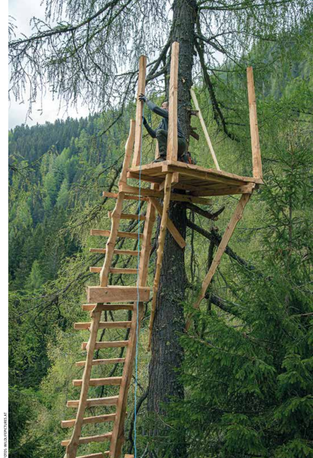
Kanzelkonstruktion. Auf die in Blickrichtung scherenförmig ausgerichteten Aufleger kommen die Bodenaufleger und darauf die Bodenbretter. An den vier Ecken werden nun die Steher für die Kanzelwände montiert und anschließend mit der entrindeten Seitenware der Lärche verkleidet.
