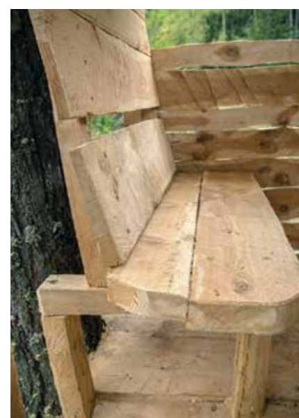
Innenausstattung. Richtig bequem machen den Sitz die leicht schräge Rückenlehne mit der Aussparung für das Schusstangl, natürlich das Ablagebrett unter der Brüstung für Spektiv und Speck sowie ein Rundling als Fußablage.
