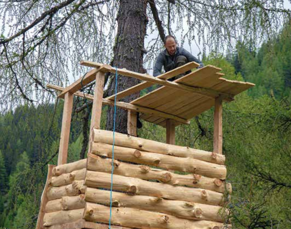
Dachdeckung. Lediglich die Dachbretter wurden aus dem Tal mitgenommen. Eine Dachpappe, noch besser Teichfolie, macht das Dach regenfest.
