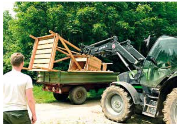
Die vorgefertigte Kanzelkonstruktion lässt sich mit einem Frontlader und Anhänger noch gut zum Aufstellplatz bringen.
