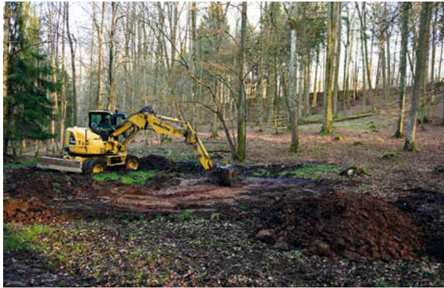
Die Errichtung von Wasserrückhaltebecken ist meist schnell geschehen. An Stellen, wo der Grundwasserspiegel hoch ist, ziehen wir mit dem Bagger eine flache Wanne aus und verdichten die Sohle entsprechend. Sie sind fortan wertvolle Wasserpuffer in der heißen Jahreszeit.
