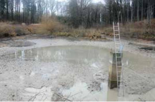
Ein Mönch sollte unbedingt mitgebaut werden. So kann man bei Bedarf für Reparaturen das Wasser ablassen oder aber den Wasserstand für die sensiblen Ufer- und Wasserpflanzen konstant halten.
